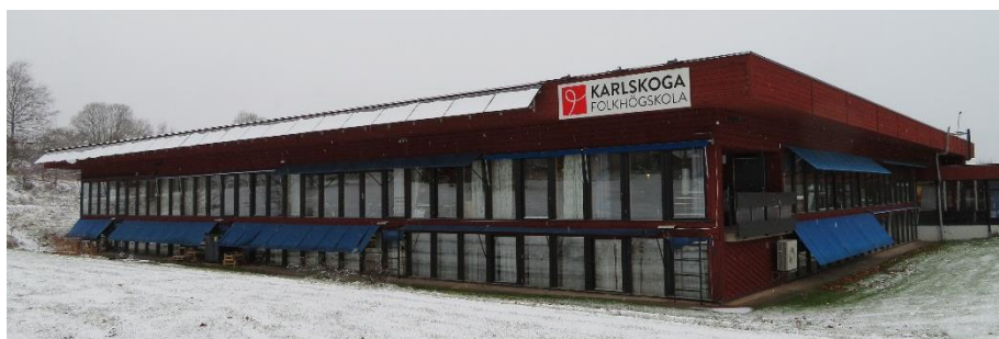
Figur 2 Befintlig solcellsanläggning vid fasaden på Huvudbyggnaden
