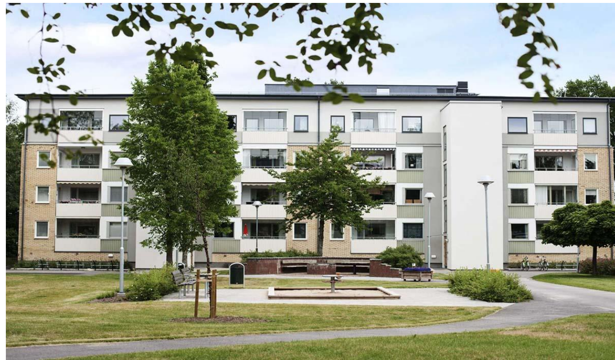
Skarpan, Riksbyggen, Linköping
