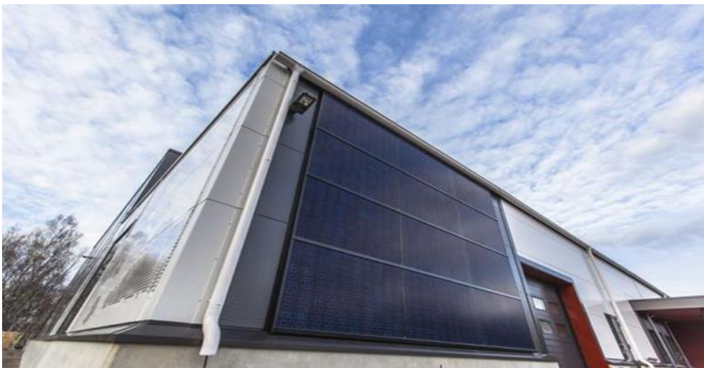
Fasadmonterade paneler på lagerhall
